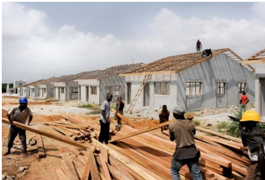
Chantier de logements sociaux à Songon
