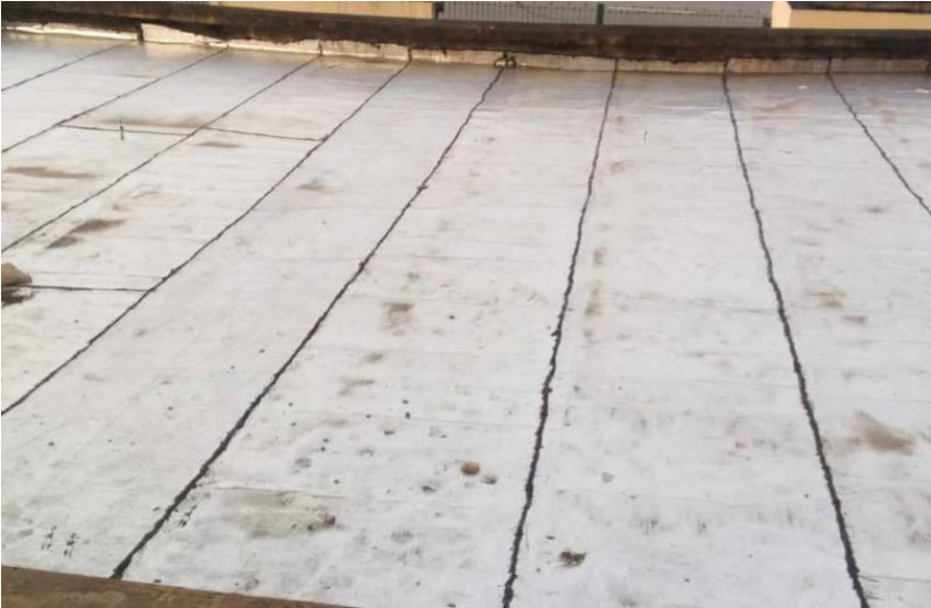
Réfection de la toiture cotée entrée principale de la DRBF
