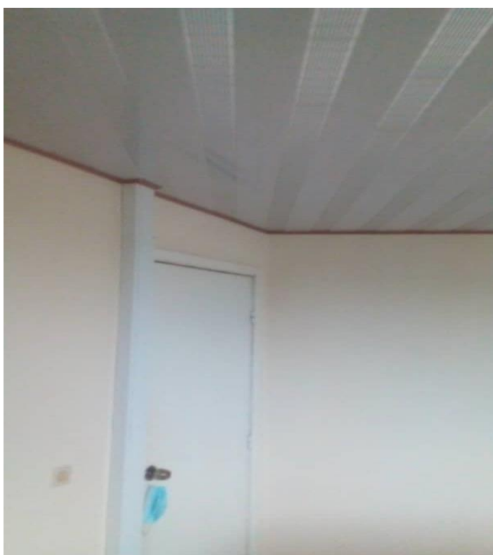
Réfection du plafond du bureau du DRBF
