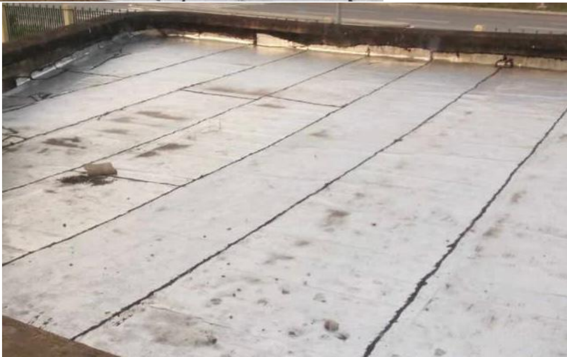
Réfection de la toiture centrale de la mini-cité financière
